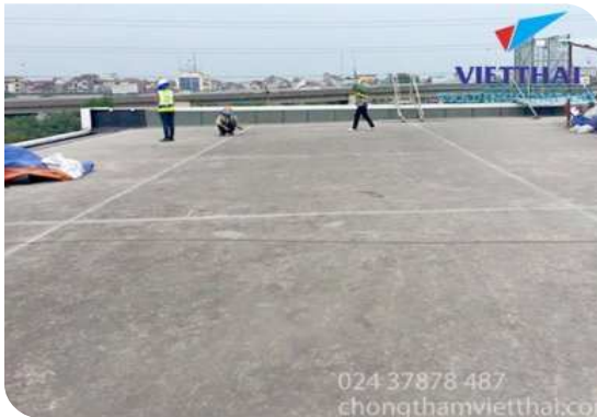
Chuẩn bị bề mặt
