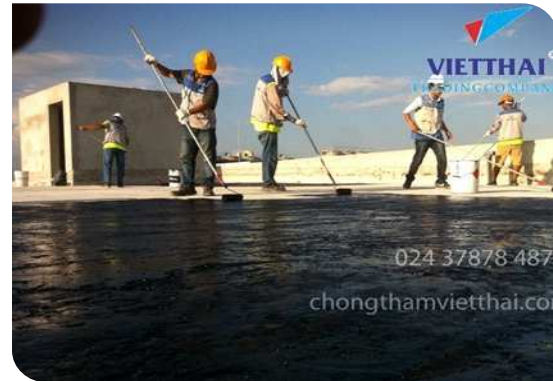
Thi công lăn lớp lót
