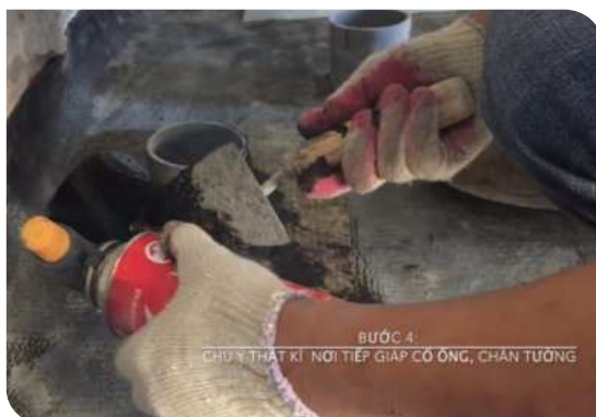
Xử lý cổ ống thoát nước
