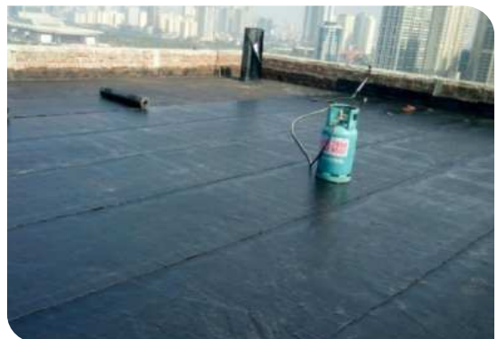
Bề mặt hoàn thiện
