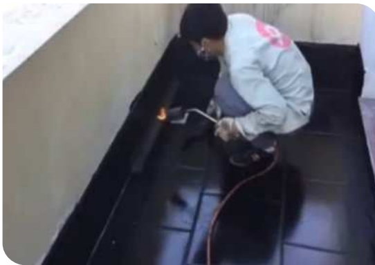
Xử lý góc chân tường
