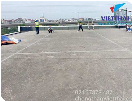
Chuẩn bị bề mặt
