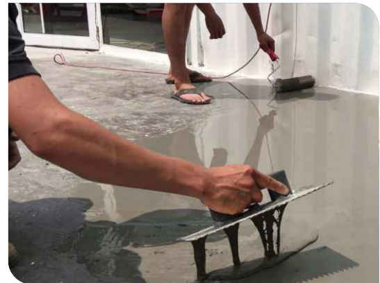
Thi công cán hồ dầu
