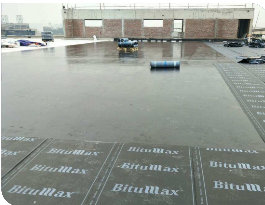
Thi công màng tự dính
