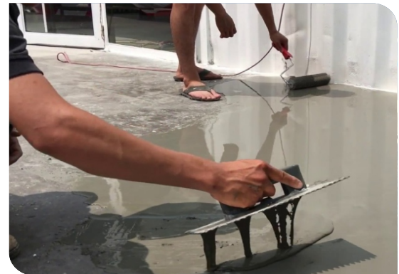
Thi công cán hồ dầu
