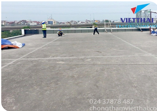
Chuẩn bị bề mặt
