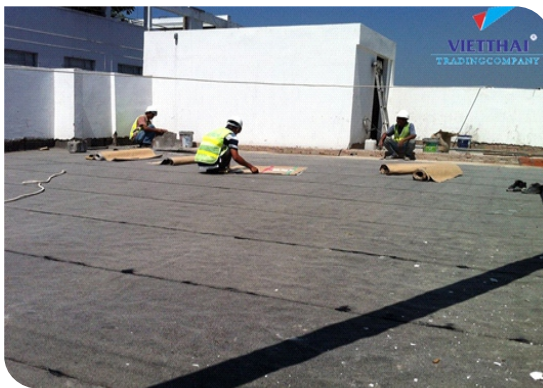
Thi công màng tự dính
