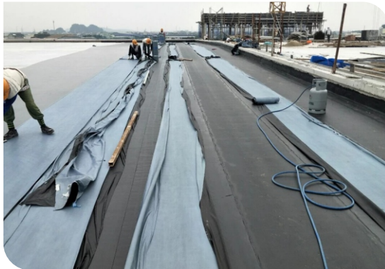
Thi công màng khò nóng
