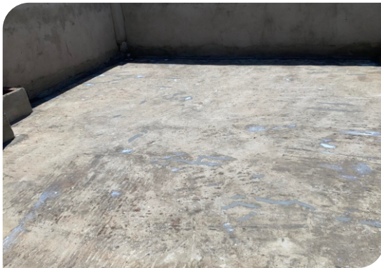
Chuẩn bị bề mặt
