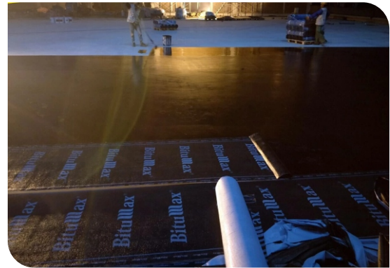
Thi công lăn lớp lót
