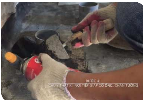
Xử lý cổ ống thoát nước
