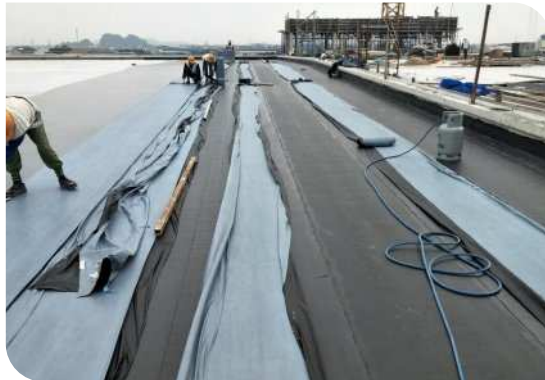
Thi công màng khò nóng
