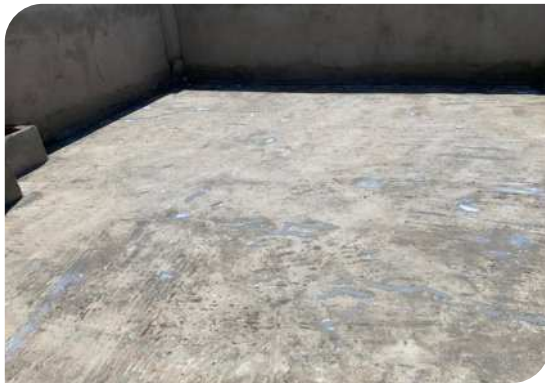
Chuẩn bị bề mặt
