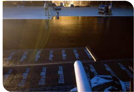
Thi công lăn lớp lót
