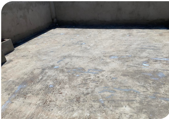
Chuẩn bị bề mặt
