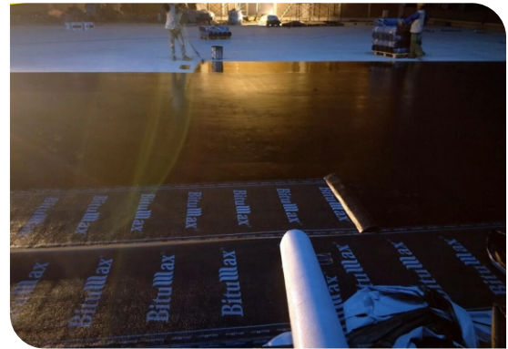
Thi công lăn lớp lót
