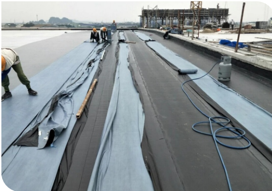
Thi công màng khò nóng
