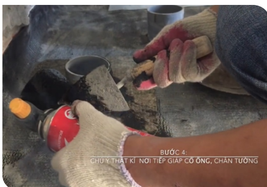
Xử lý cổ ống thoát nước
