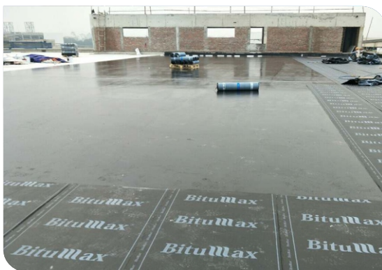
Thi công màng tự dính
