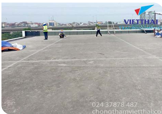
Chuẩn bị bề mặt
