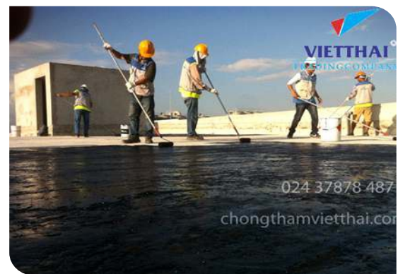
Thi công lăn lớp lót
