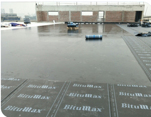
Thi công màng tự dính
