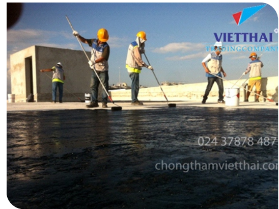
Thi công lăn lớp lót
