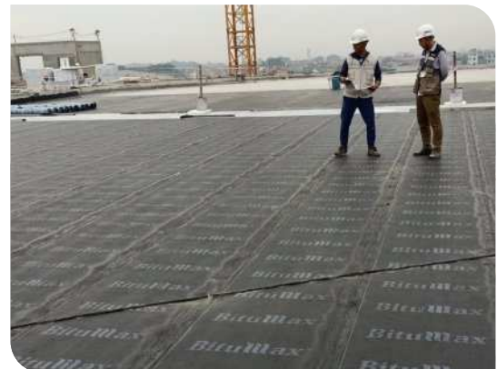
Bề mặt hoàn thiện
