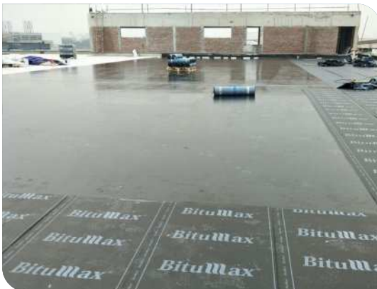
Thi công màng tự dính
