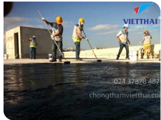
Thi công lăn lớp lót
