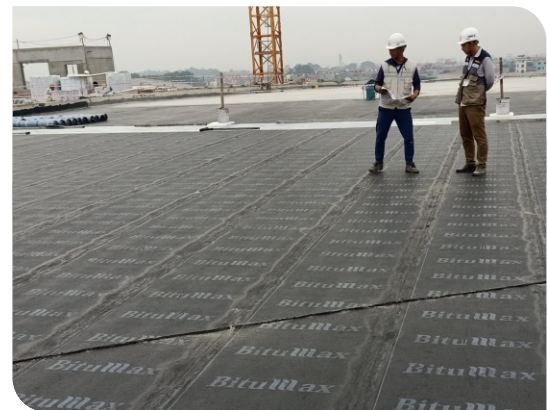
Bề mặt hoàn thiện
