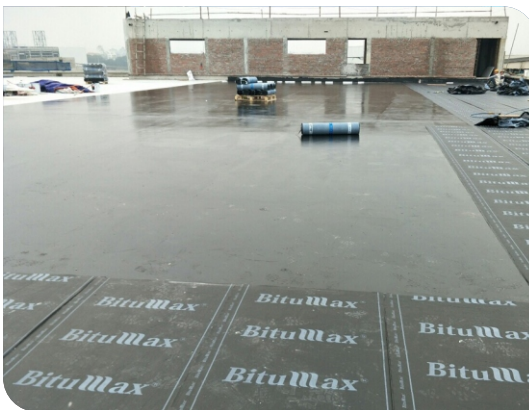
Thi công màng tự dính
