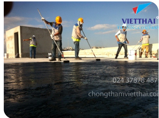
Thi công lăn lớp lót
