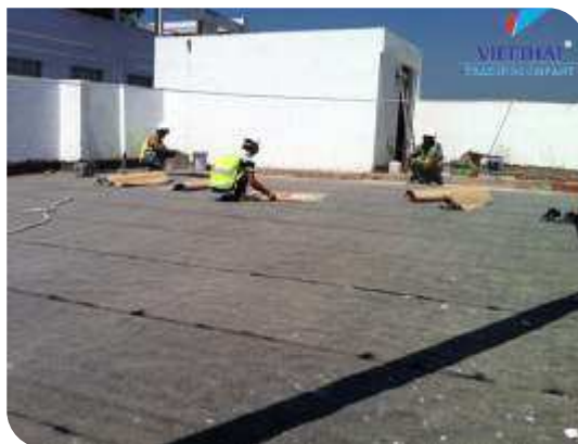
Thi công màng tự dính
