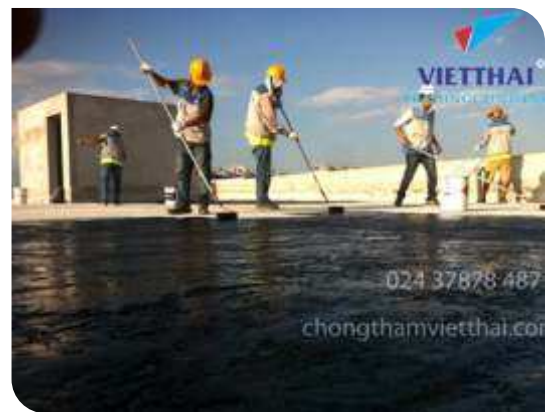
Thi công lăn lớp lót
