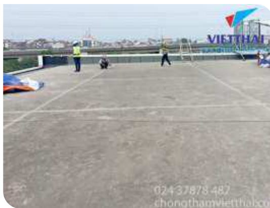
Chuẩn bị bề mặt
