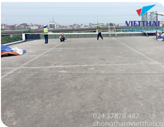
Chuẩn bị bề mặt
