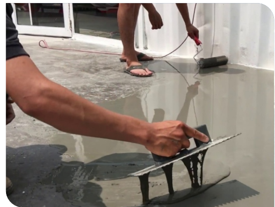
Thi công cán hồ dầu
