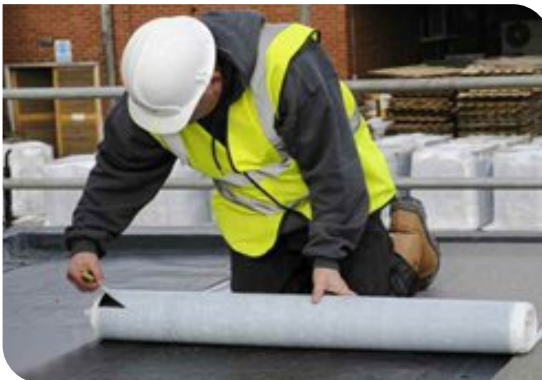
Thi công màng tự dính
