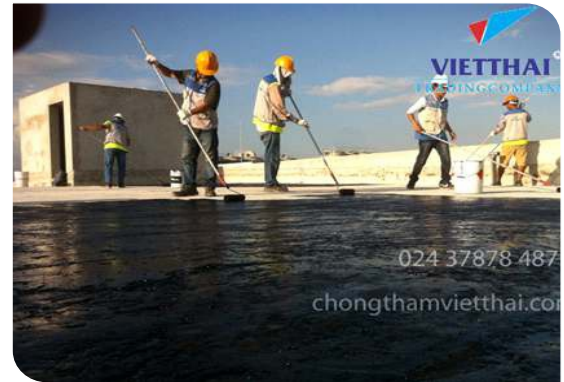
Thi công lăn lớp lót
