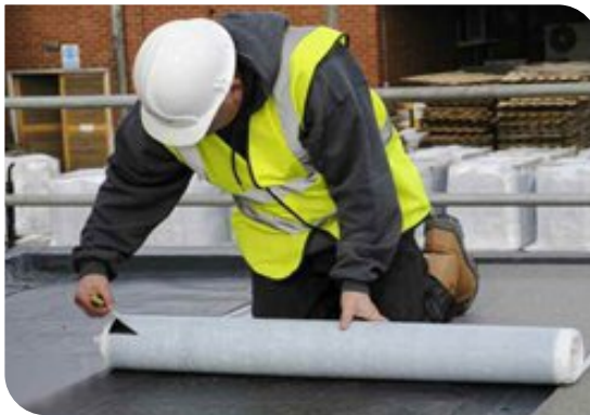
Thi công màng tự dính
