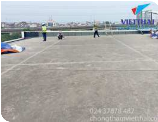
Chuẩn bị bề mặt
