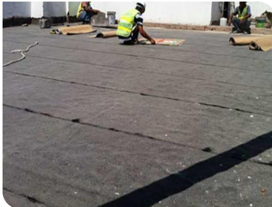
Thi công màng tự dính
