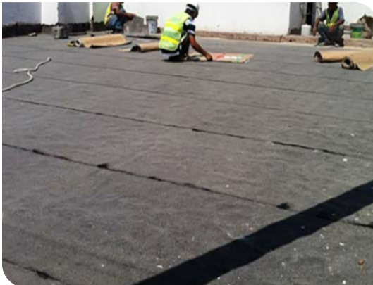
Thi công màng tự dính
