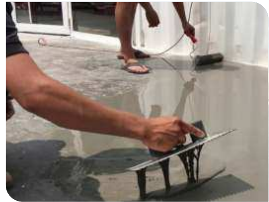
Thi công cán hồ dầu
