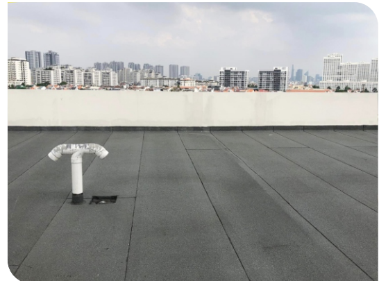
Bề mặt hoàn thiện
