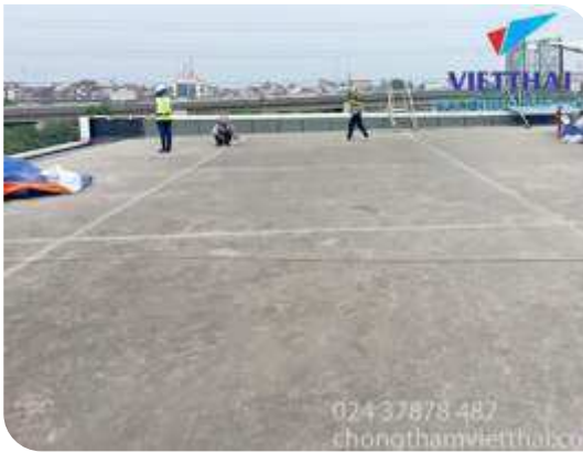
Chuẩn bị bề mặt
