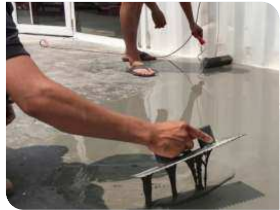
Thi công cán hồ dầu
