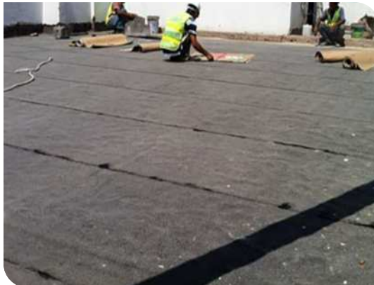
Thi công màng tự dính
