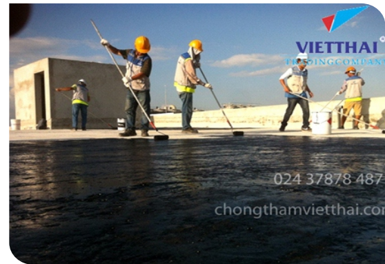
Thi công lăn lớp lót
