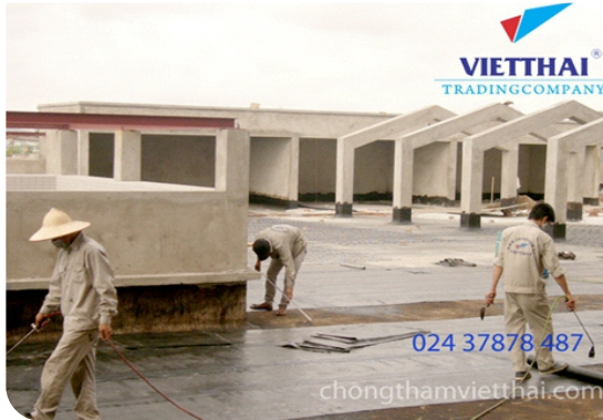
Thi công màng khô nóng
