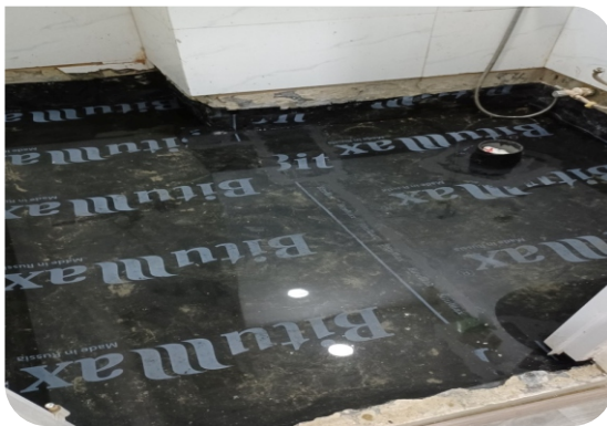
Thi công màng tự dính
