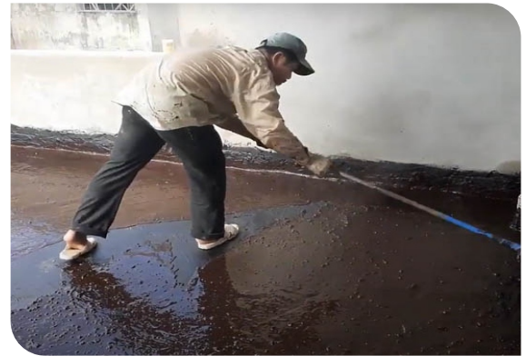
Thi công lăn lớp lót
