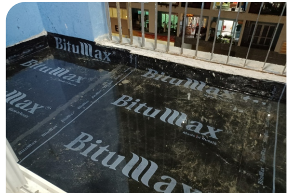
Bề mặt hoàn thiện
