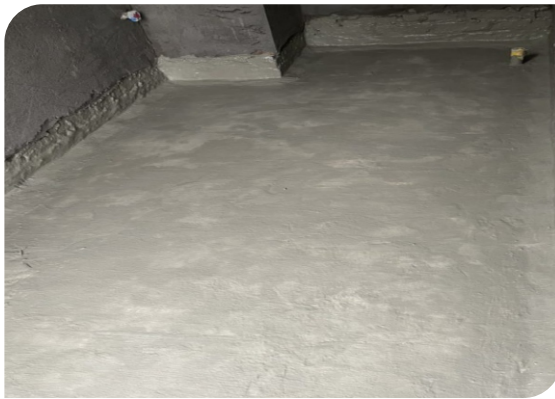
Chuẩn bị bề mặt
