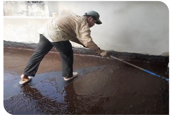
Thi công lăn lớp lót
