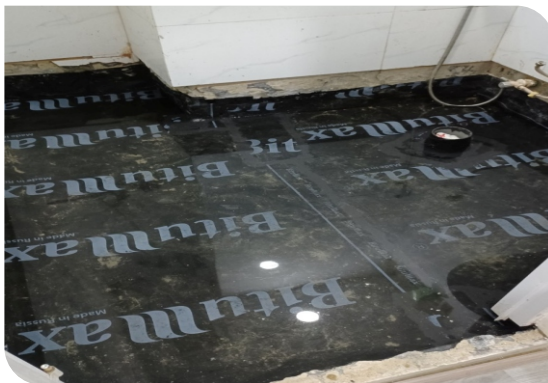
Thi công màng tự dính
