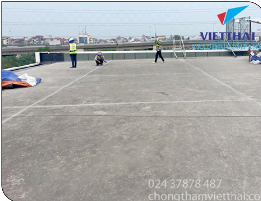
Chuẩn bị bề mặt
