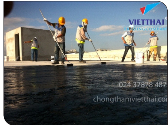
Thi công lăn lớp lót
