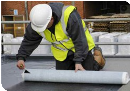
Thi công màng tự dính
