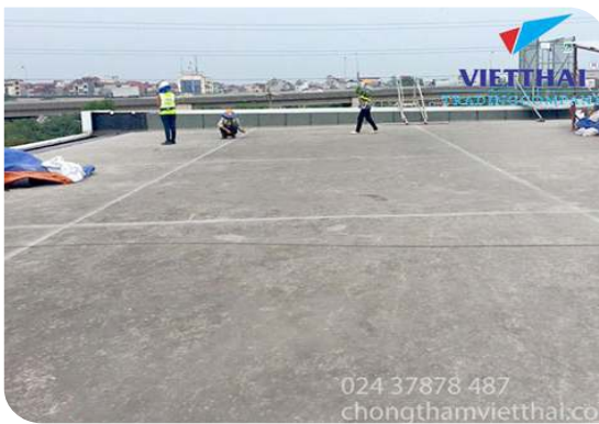
Chuẩn bị bề mặt
