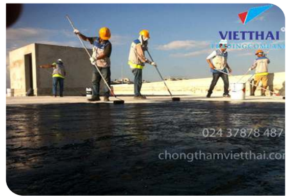
Thi công lăn lớp lót
