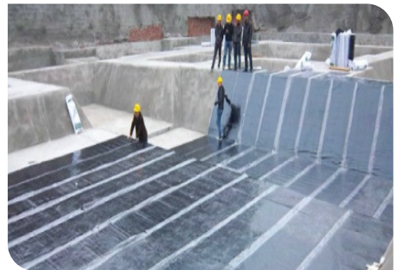
Bề mặt hoàn thiện
