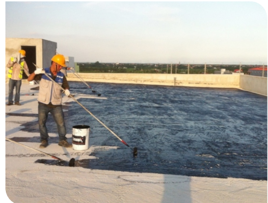
Thi công lăn lớp lót
