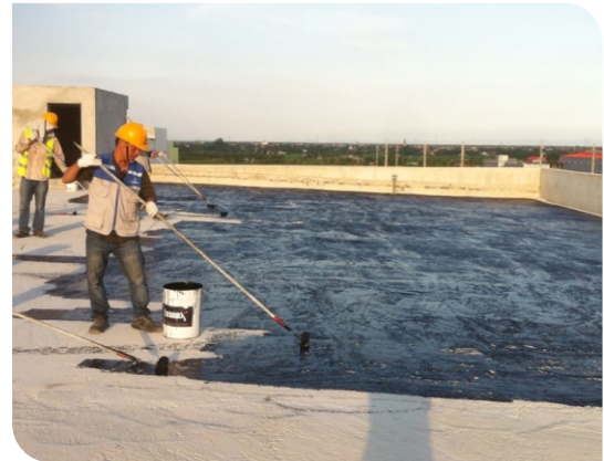
Thi công lăn lớp lót
