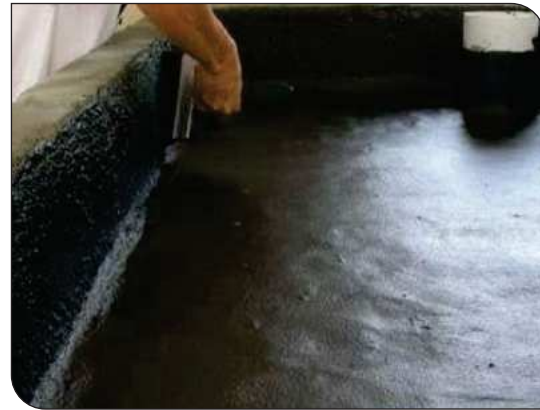
Thi công lăn lớp lót
