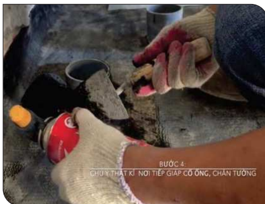
Xử lý cổ ống thoát nước
