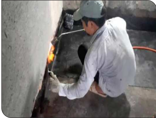
Thi công màng khò nóng
