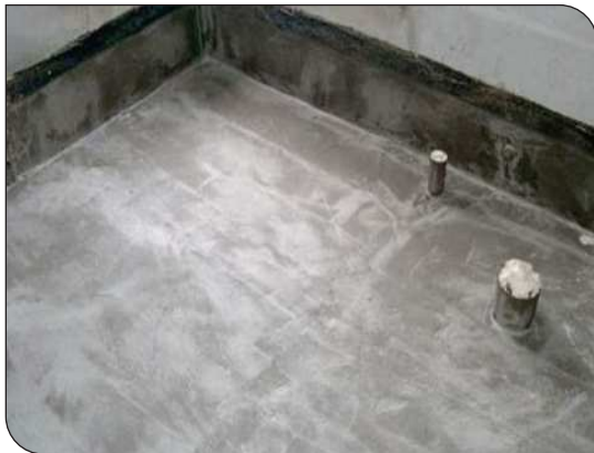
Chuẩn bị bề mặt
