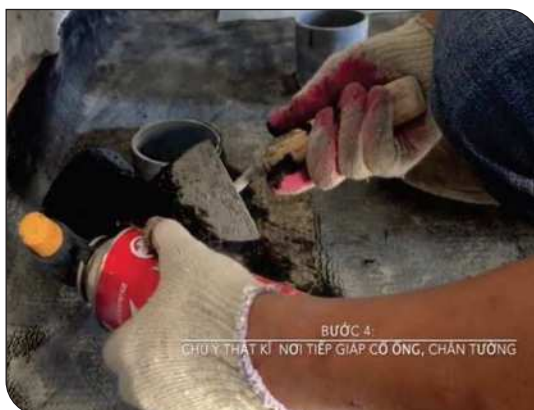
Xử lý cổ ống thoát nước
