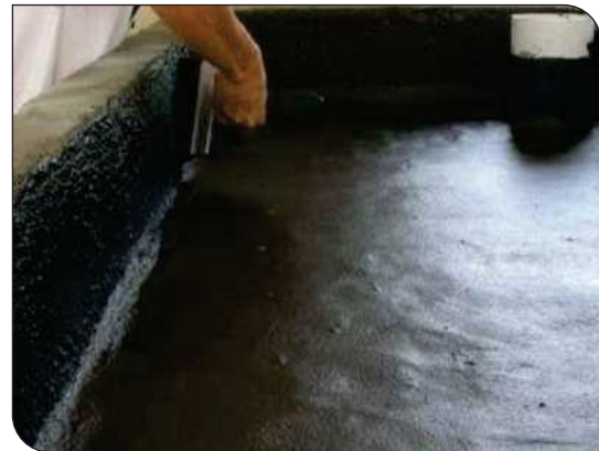
Thi công lăn lớp lót
