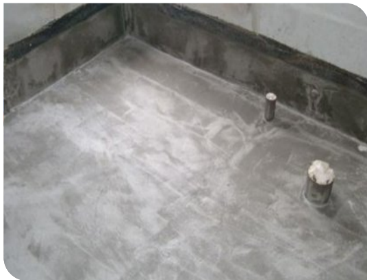
Chuẩn bị bề mặt
