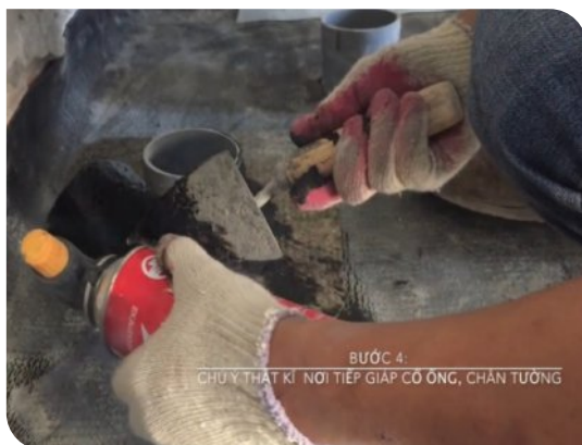
Xử lý cổ ống thoát nước
