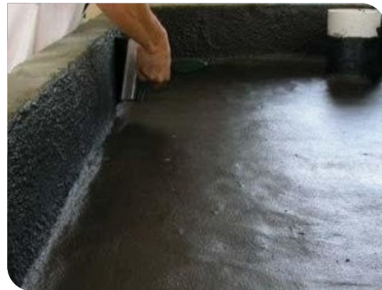
Thi công lăn lớp lót
