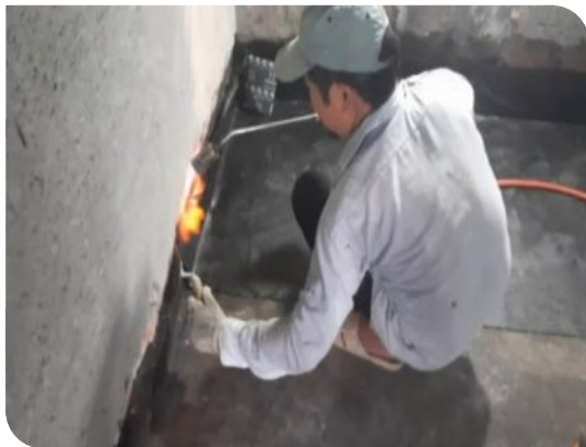
Thi công màng khô nóng
