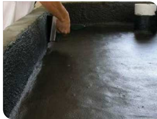
Thi công lăn lớp lót
