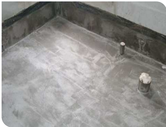
Chuẩn bị bề mặt
