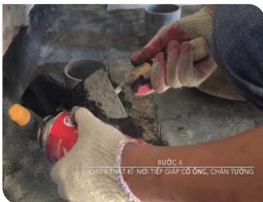
Xử lý cổ ống thoát nước
