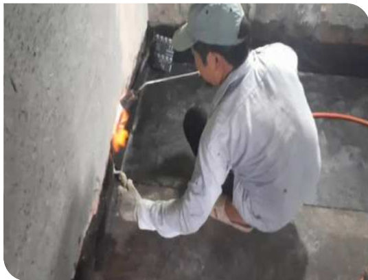
Thi công màng khô nóng
