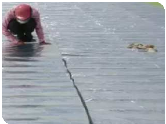
Bề mặt hoàn thiện
