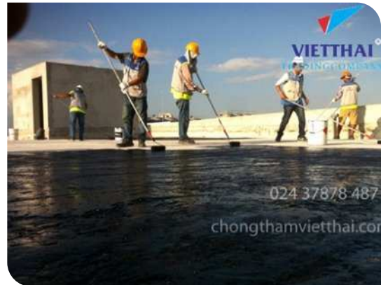
Thi công lăn lớp lót
