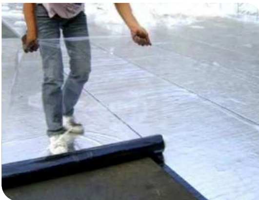
Thi công màng tự dính mặt nhôm
