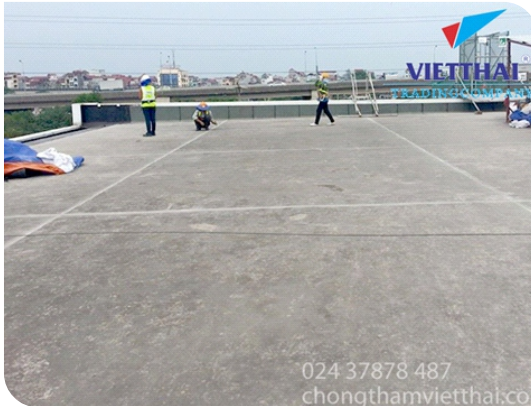
Chuẩn bị bề mặt
