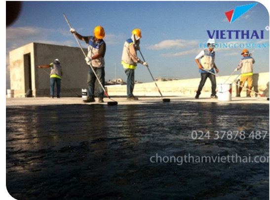
Thi công lăn lớp lót
