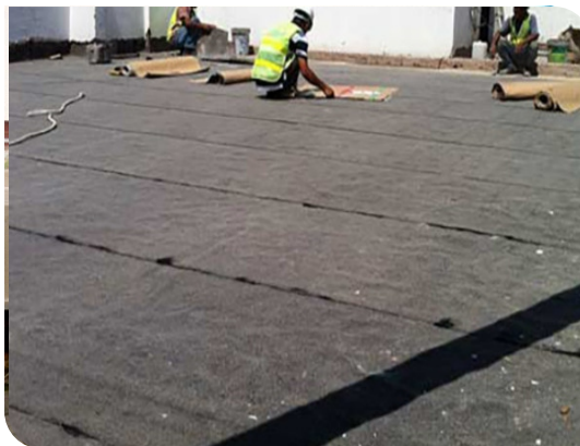
Thi công màng tự dính
