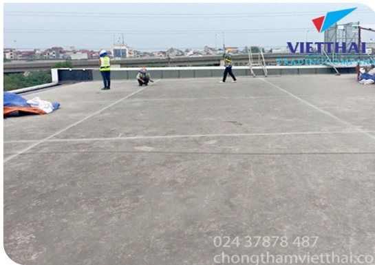
Chuẩn bị bề mặt
