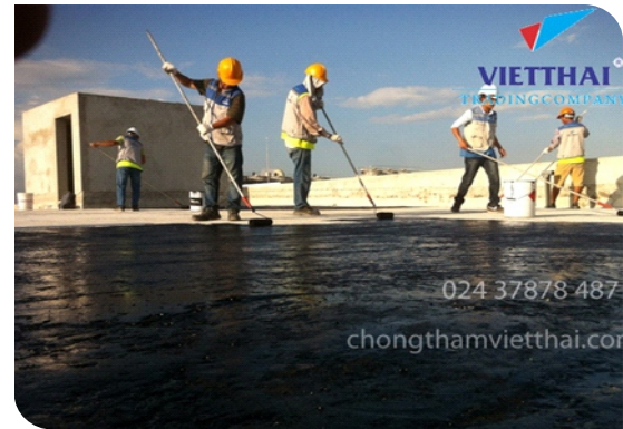
Thi công lăn lớp lót
