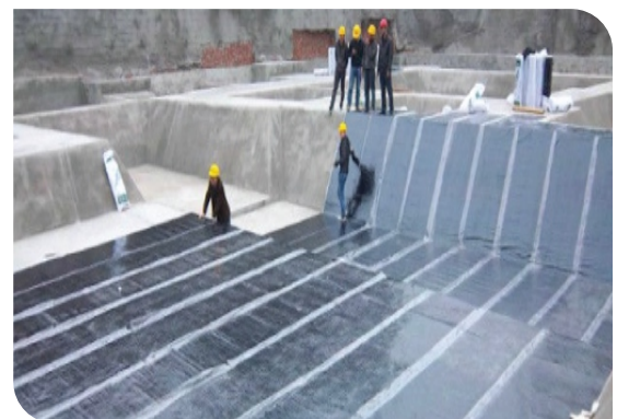
Bề mặt hoàn thiện
