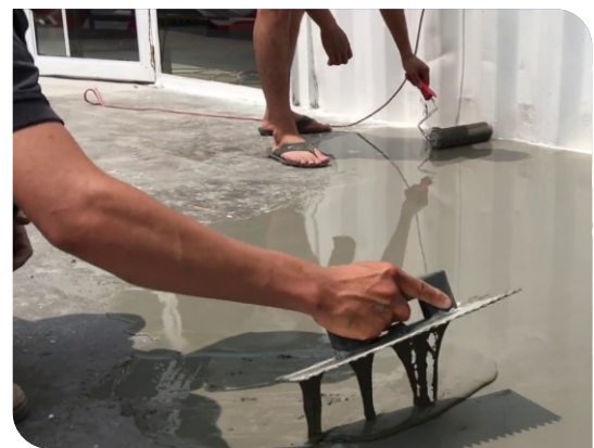
Thi công cán hồ dầu
