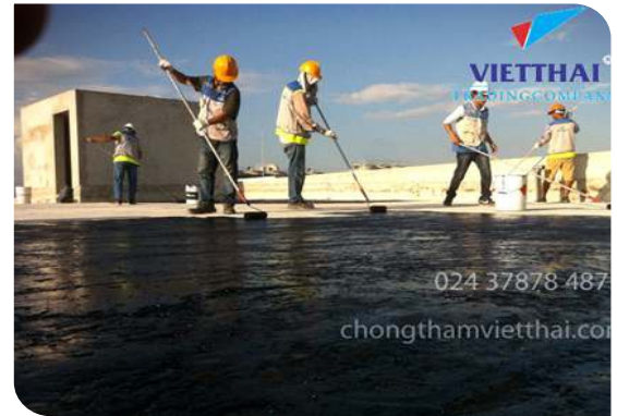
Thi công lăn lớp lót
