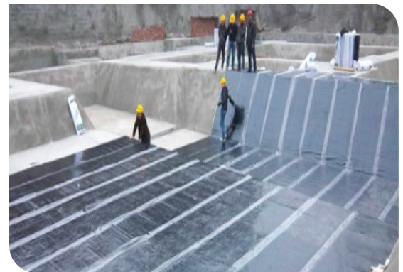
Bề mặt hoàn thiện
