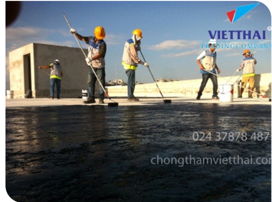
Thi công lăn lớp lót
