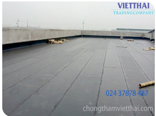
Bề mặt hoàn thiện
