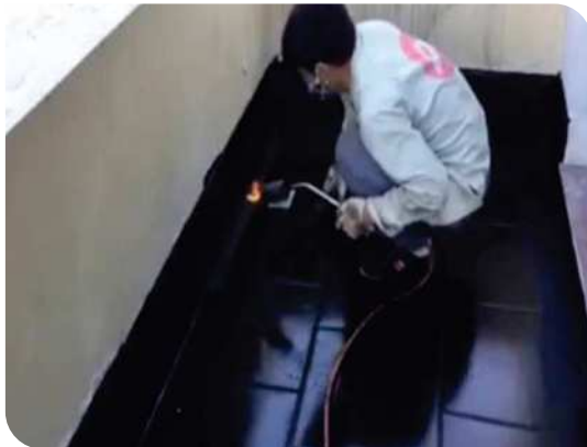
Xử lý góc chân tường
