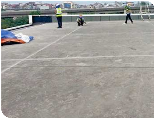
Chuẩn bị bề mặt
