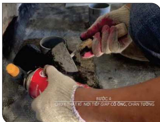
Xử lý cổ ống thoát nước
