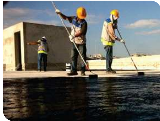
Thi công lăn lớp lót
