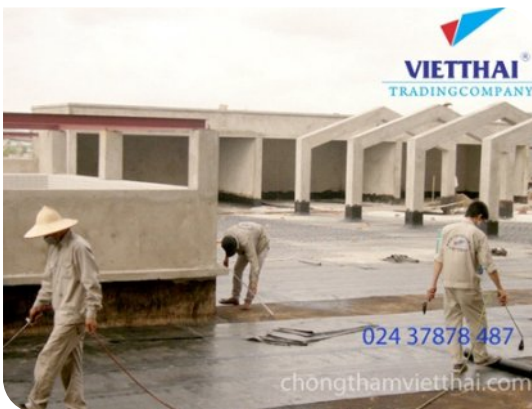
Thi công màng khô nóng
