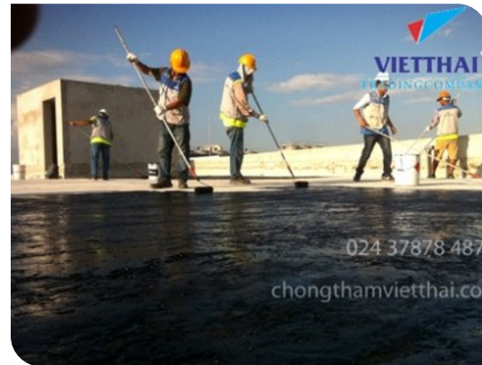
Thi công lăn lớp lót
