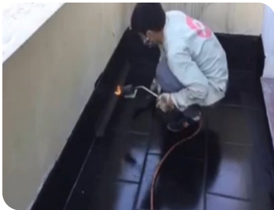
Xử lý góc chân tường
