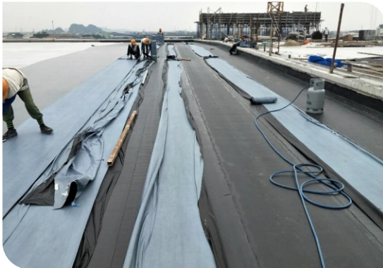
Thi công màng khò nóng
