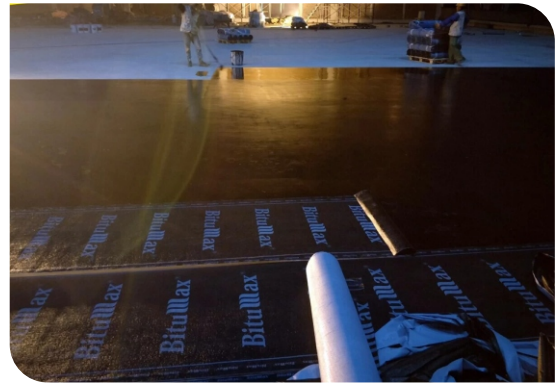
Thi công lăn lớp lót
