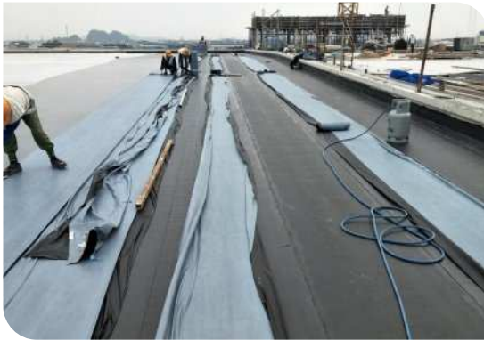
Thi công màng khô nóng
