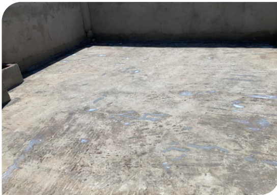
Chuẩn bị bề mặt
