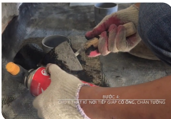
Xử lý cổ ống thoát nước
