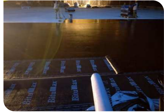
Thi công lăn lớp lót
