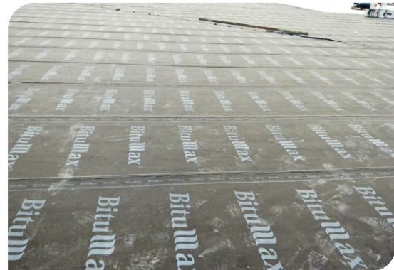
Bề mặt hoàn thiện
