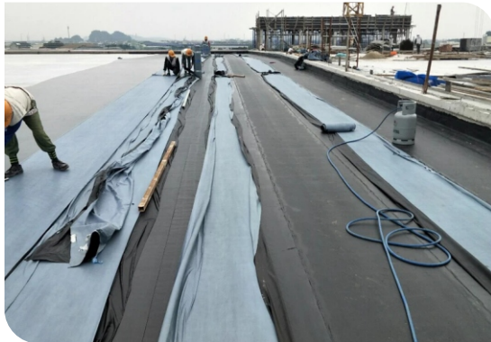
Thi công màng khò nóng
