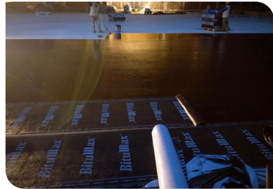
Thi công lăn lớp lót
