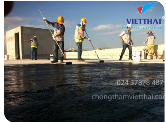
Thi công lăn lớp lót
