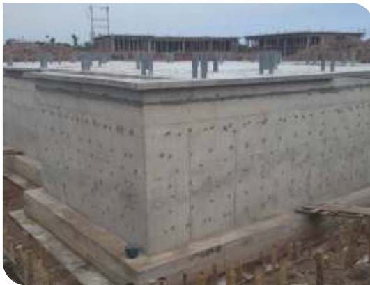
Chuẩn bị bề mặt
