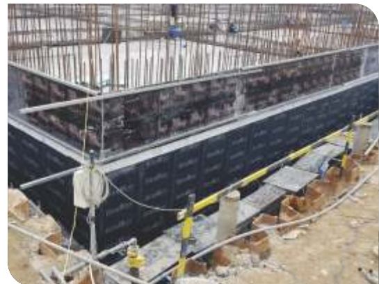
Bề mặt hoàn thiện
