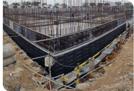
Bề mặt hoàn thiện
