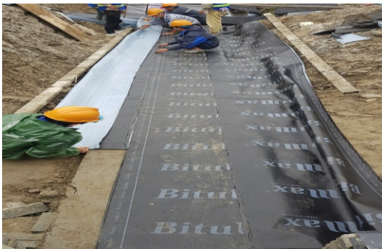
Thi công màng tự dính
