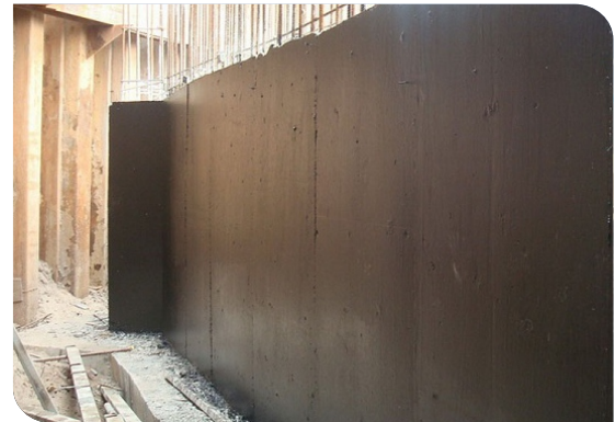
Thi công lăn lớp lót
