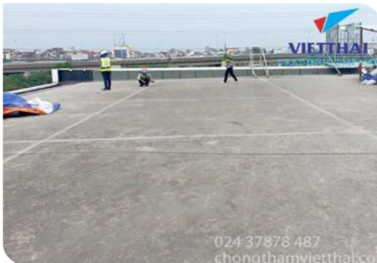
Chuẩn bị bề mặt
