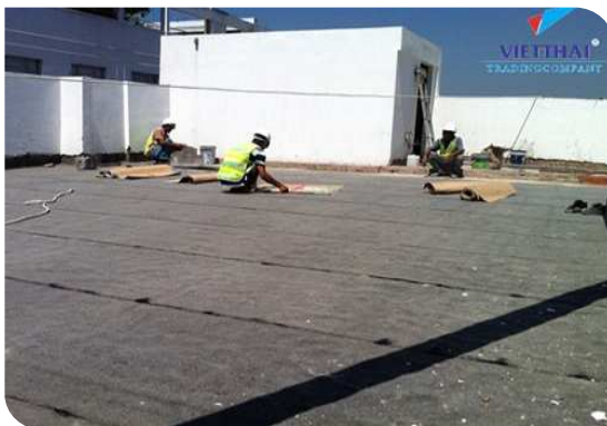
Thi công màng tự dính
