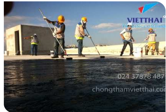
Thi công lăn lớp lót
