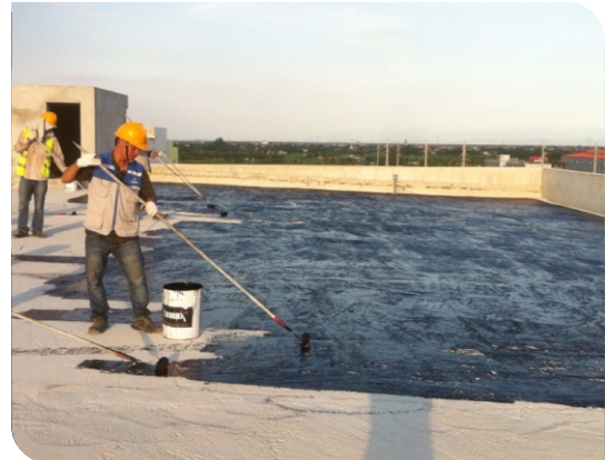
Thi công lăn lớp lót
