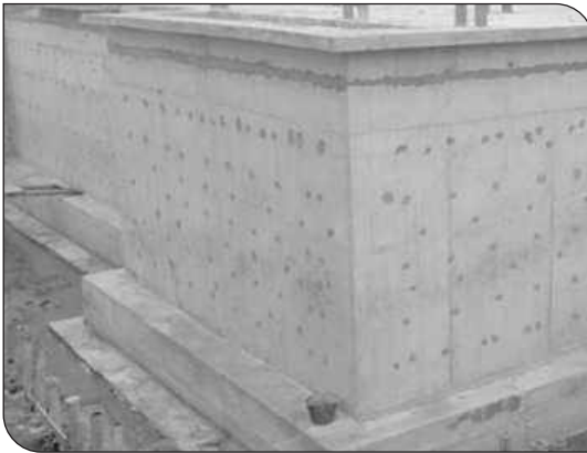
Chuẩn bị bề mặt
