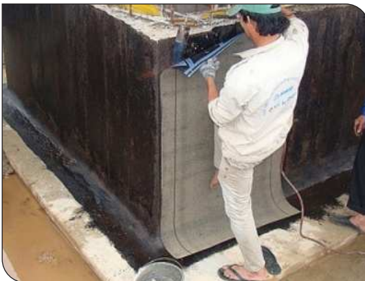
Thi công màng khô nóng
