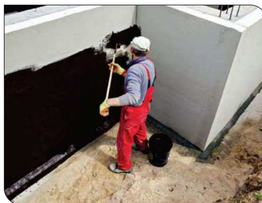
Thi công lăn lớp lót
