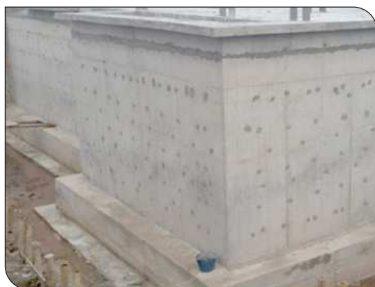
Chuẩn bị bề mặt
