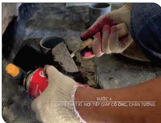
Xử lý cổ ống thoát nước
