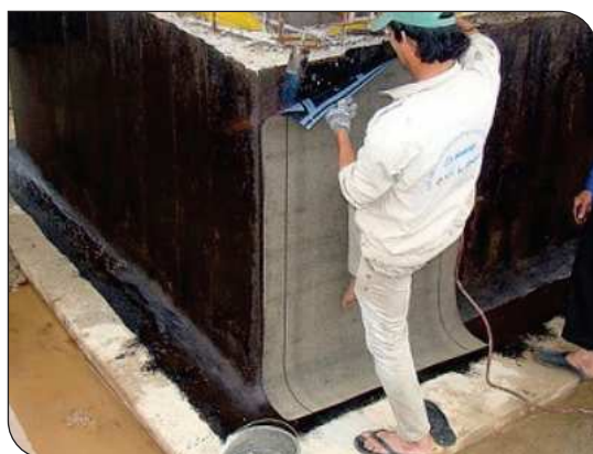
Thi công màng khô nóng
