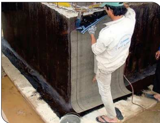
Thi công màng khô nóng
