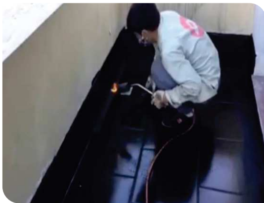
Xử lý góc chân tường
