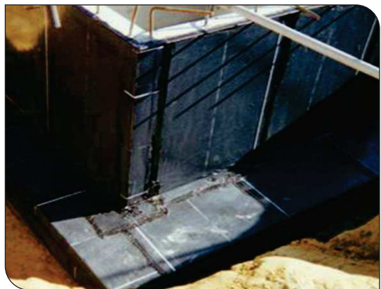
Bề mặt hoàn thiện
