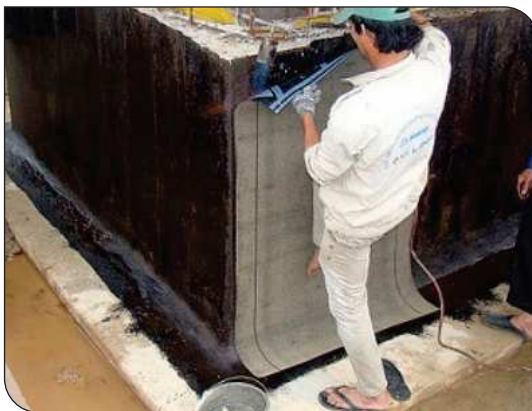
Thi công màng khô nóng
