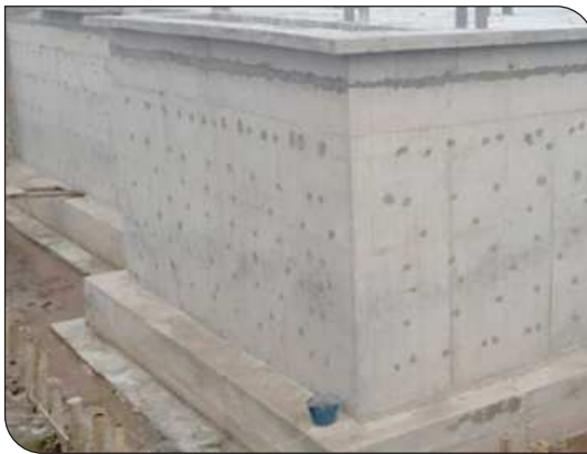
Chuẩn bị bề mặt
