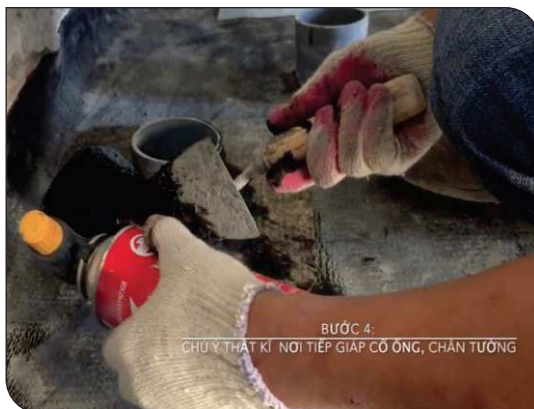
Xử lý cổ ống thoát nước
