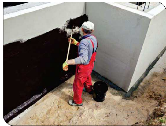
Thi công lăn lớp lót
