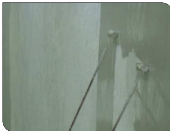
Thi công Silimper® Nano
