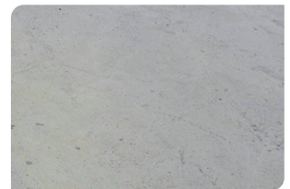
Bề mặt bê tông đạt
