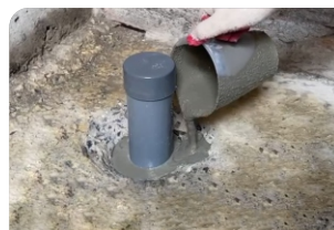
Thi công đổ vữa Lemax Grout LM-G650
